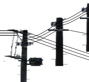
電柱・電線など
